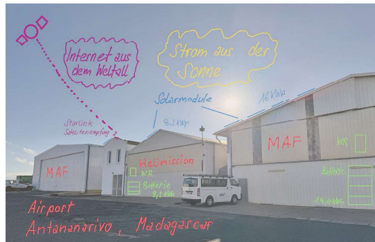
Neun Handwerker werden in Madagaskar Solaranlagen installieren
